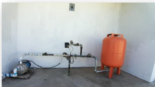
Cambio de bomba de agua de pozo profundo que alimenta principalmente a la cisterna general.
