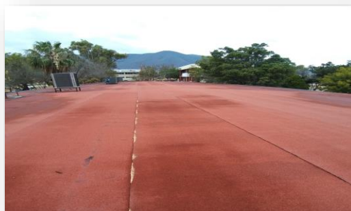
Impermeabilización en edificios y aulas
